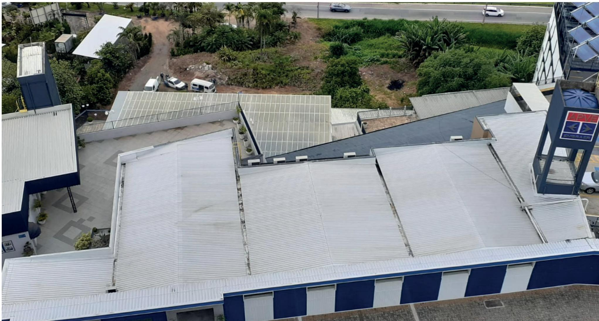
**NOVO TELHADO** *Substituição completa do telhado da sede. Solução definitiva para os problemas com vazamentos crônicos garantindo grande redução de custos com obras emergenciais e paliativas.*
