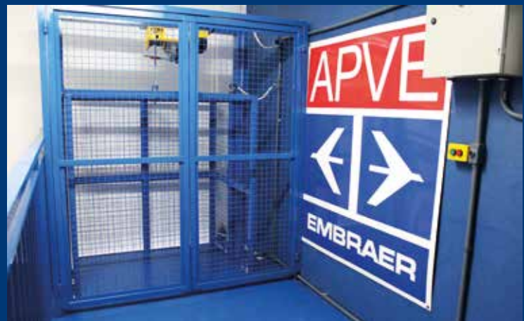
Elevador que passa a atender Salão D no transporte de cargas, mantimentos e equipamentos. Na foto abaixo vista parcial do Salão com capacidade para 192 pessoas
