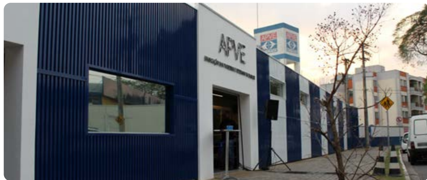
2020 - Nova fachada da APVE
